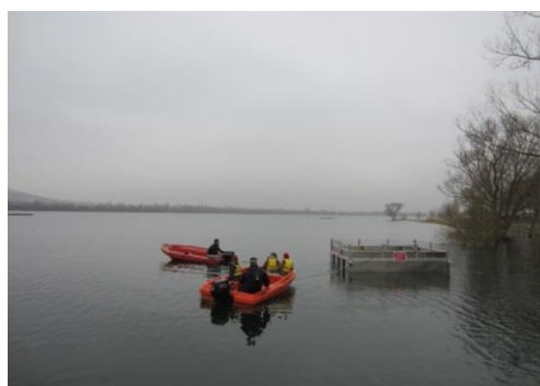
Figure 3 : installation du radeau à
